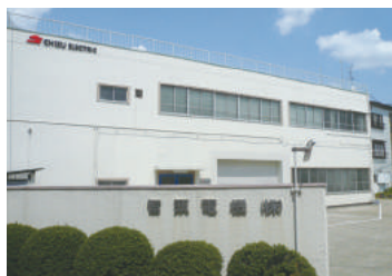
産業用機械設備の生産を担う本社の外観
