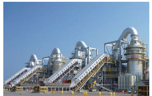
エプロンコンベヤでガレキ処理
