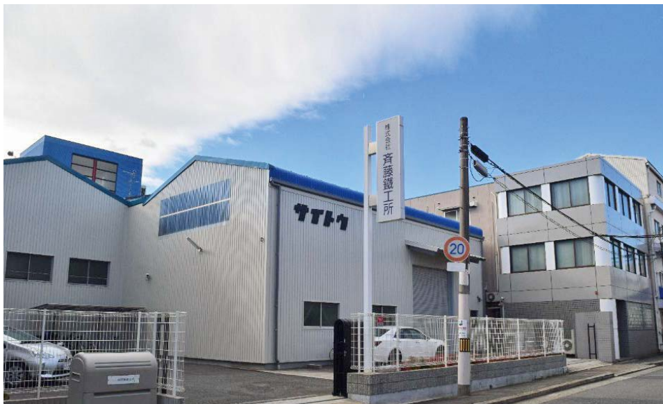
水門・水処理設備を製造する本社工場
