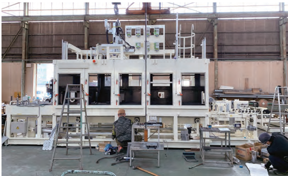
洗浄装置の組込作業
