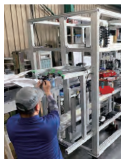
包装ライン設備組込作業
