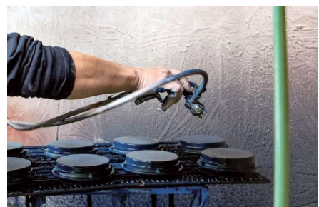
塗装作業の様子
