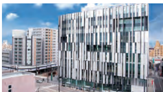
外壁材パネルを施工した富山市内の複合ビル
