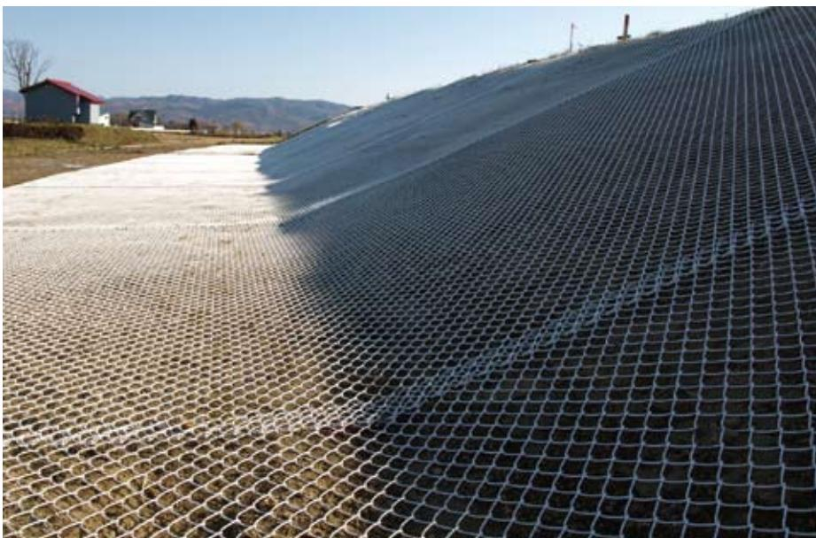
同社のワイヤを使用した敷き網。高尺ネット、防球ネット、落石防止網等、使用用途は多岐にわたる
